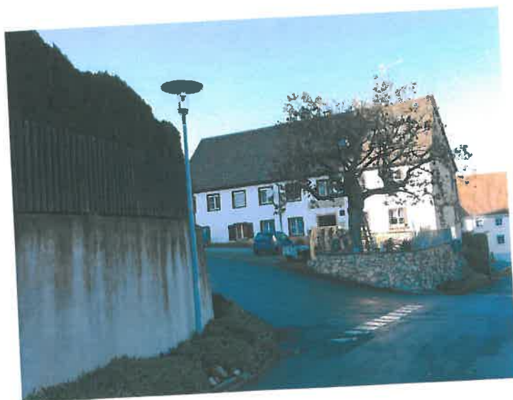
Bereich Hilzinger Straße (Nov. 2018)
