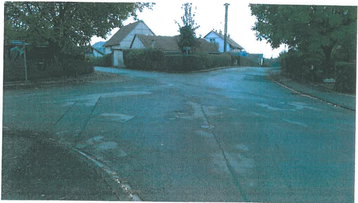
Beispiel für noch durchzuführende Absenkungen
